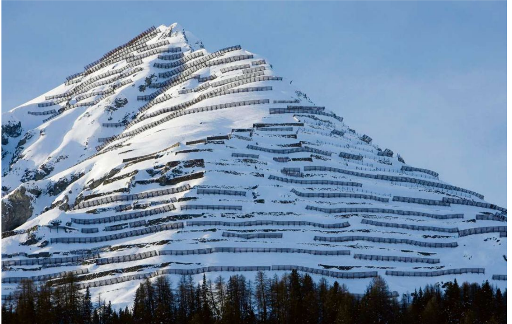
Davos Parsenn: Lawinengebäude verhindern das Abrutschen des Schnees. (FOTO ALESSANDRO DELLA BELLA / KEYSTONE)
